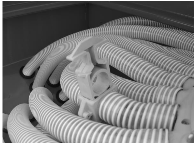
Obr. 34 mechanická klapka namontovaná na rozdělovači
