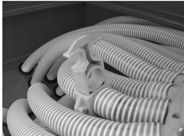
Obr. 34 mechanická klapka namontovaná na rozdělovači
